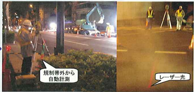
TSによる出来形計測
