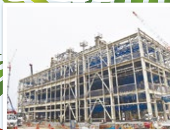
常陸那珂共同火力発電所 建設見学
